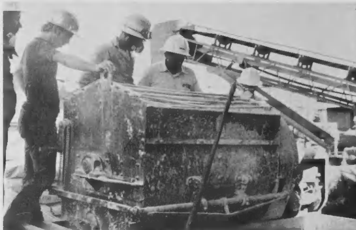
Special mixer to prepare refractory mortar to build wall. Un mezclador special pa prepara mezcla pa basha muraya.
